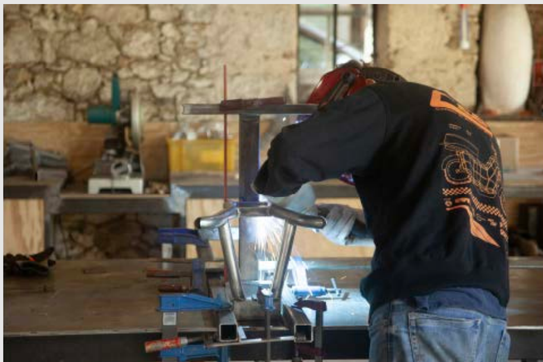
Soudure de la structure du bloc de selle
