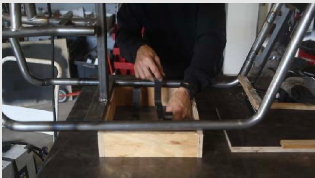
Positionnement et soudure des tôles de support
